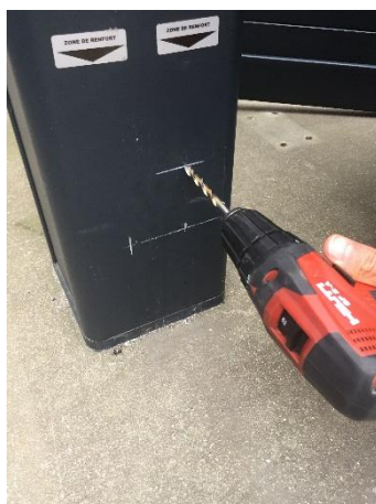
Perçage Ø 6,5mm
