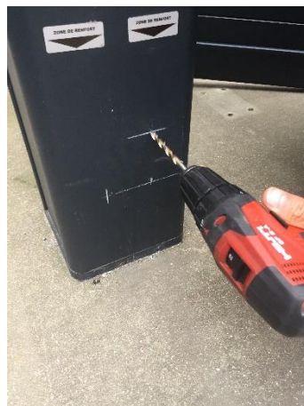
Perçage Ø 6,5mm
